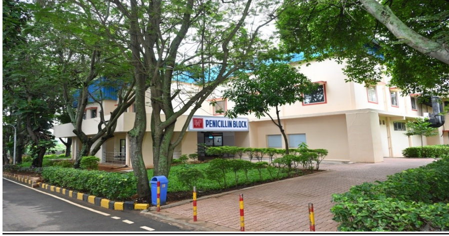
पीन्या विनिर्माण इकाई पेनिसिलिन ब्लॉक
